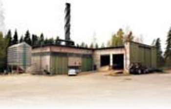
Vapon lämpökeskus Vekaranjärven varuskunnassa.
